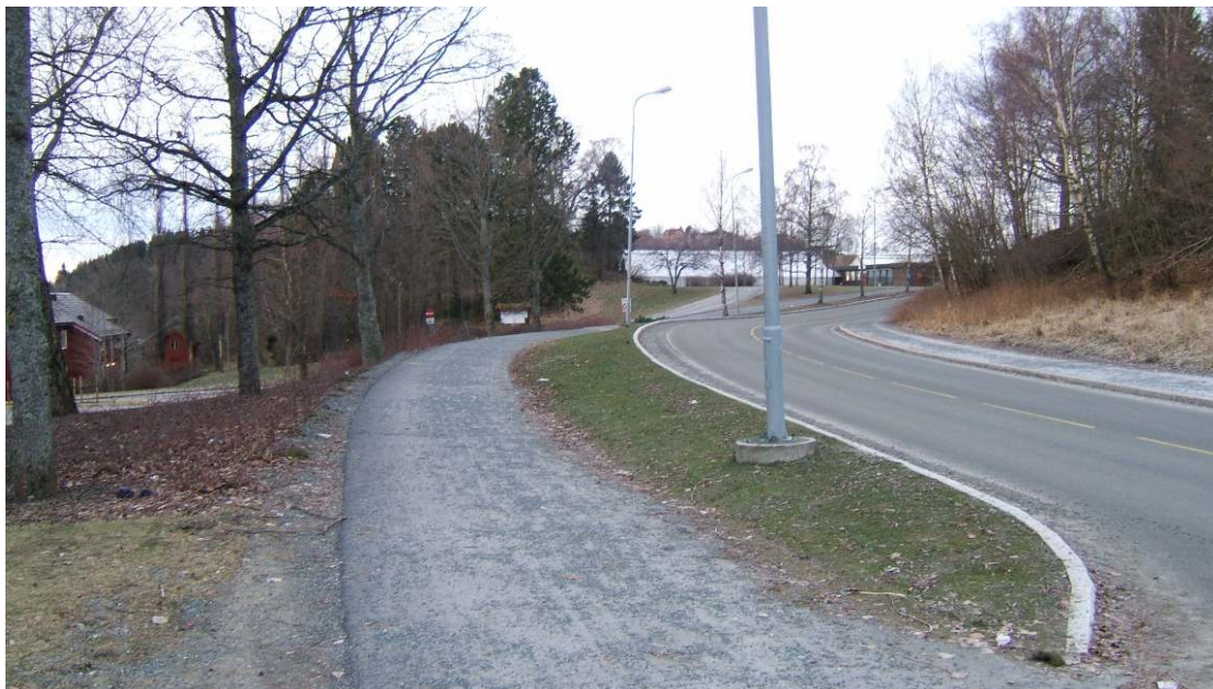
Staupslia, nyrenovert gang-/sykkelveg - fortau
