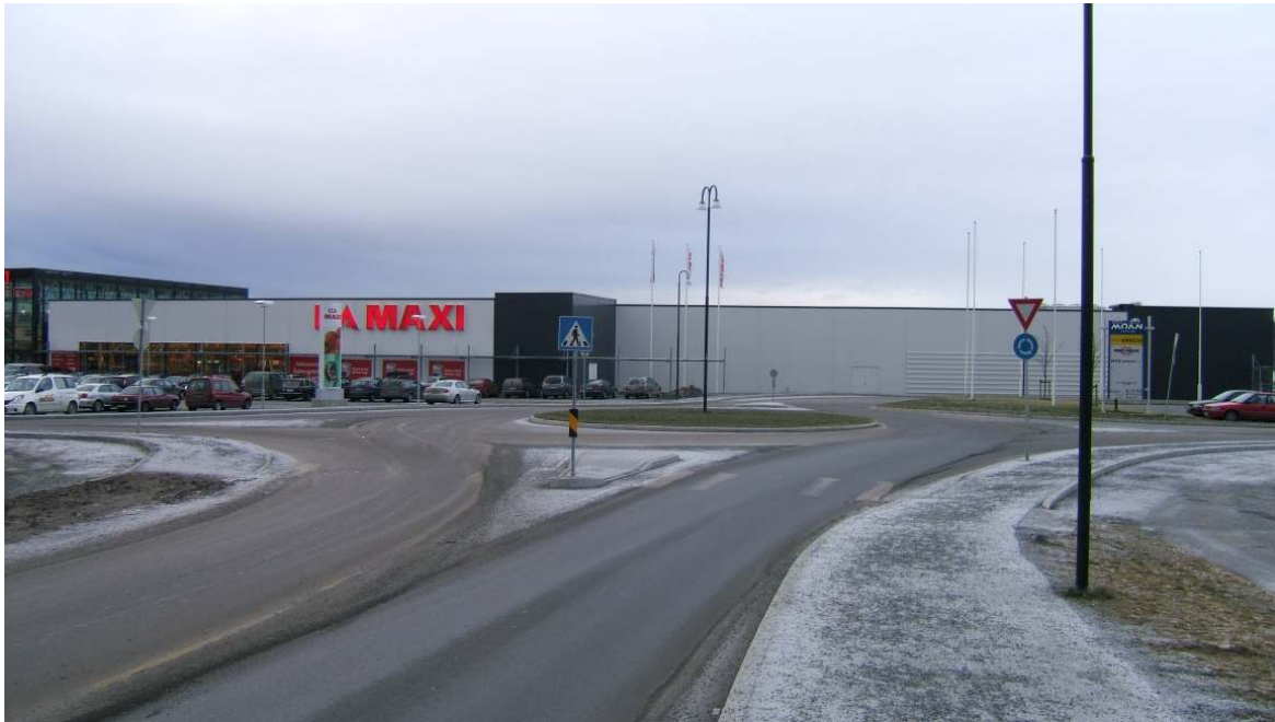
Eksempel på rundkjøring og trafikkøyer uten beplantning og med god sikt
