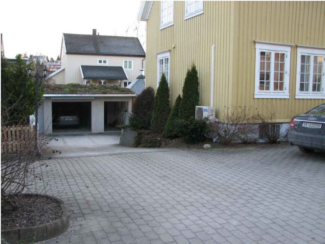
Bildet viser muren som er foreslått som ny eiendomsgrense.
